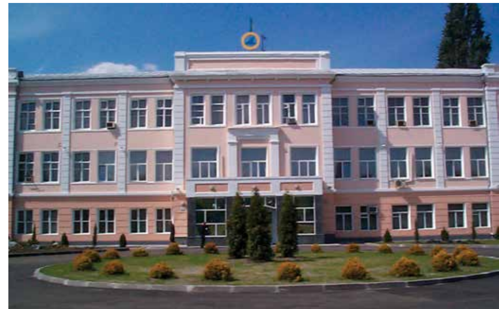
Адміністративний корпус Павлоградського хімічного заводу Administration building of Pavlograd Chemical Plant
