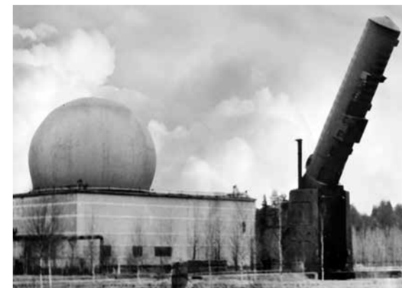
РЛС супроводження протиракетки (ліворуч) і пускова установка протиракетки (праворуч)
